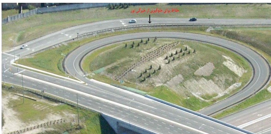
شکل ۳-۳۶ - نصب حفاظ برای جلوگیری از خیرگی نور
